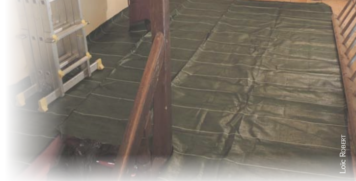
Pose d'une bâche de protection sur le plancher d'une église
