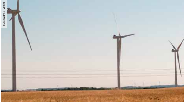
▲ Les éoliennes placées dans les grandes cultures sont généralement moins impactantes pour les chauves-souris.
