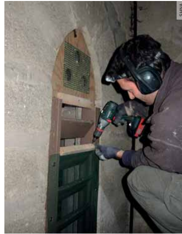
▲ Aménagement d'un clocher d'église à La Grande-Verrière (71) afin de maintenir l'accès pour les chauves-souris et éviter l'intrusion de pigeons.
