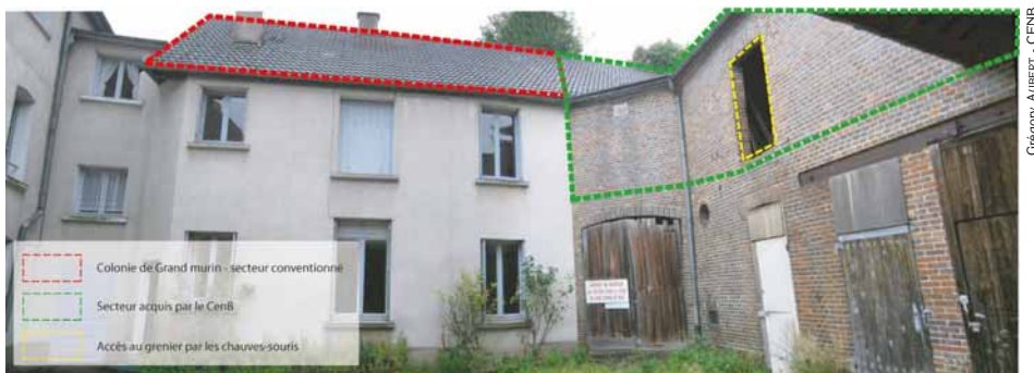
Figure 2. Vue d'ensemble du bâtiment.
