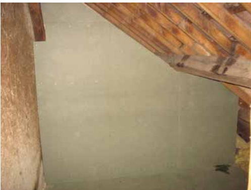
Photographie 4. Nouveaux aménagements réalisés dans le grenier.
