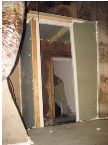
Photographie 5. Création du sas devant la porte d'entrée.
